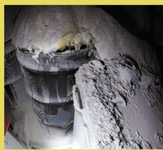
Figure 6: Fût zone 7 après explosion (Source: Sortir du nucléaire n°62)
